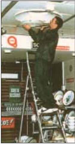
Intervention sur une bouche de soufflage
