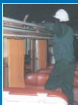
Intervention sur voiture Corail
